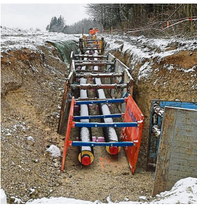
Geothermie-Wärme fürs Arbeiten: Die Gemeindewerke verlegen derzeit Leitungen zwischen der Alten Au und dem Gewerbegebiet bei Föching.
